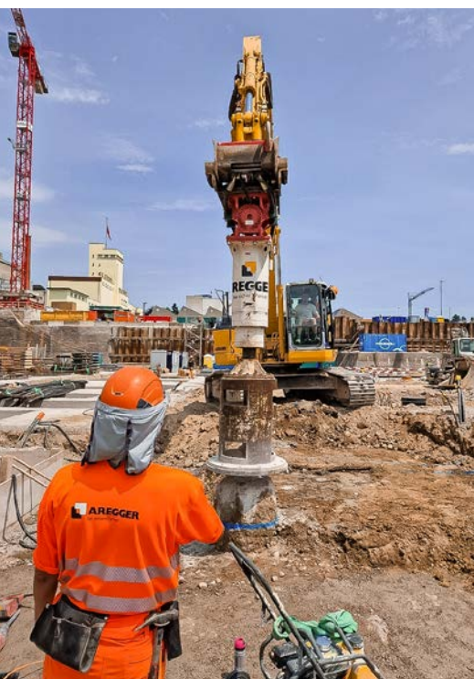
Die Bohrpfähle werden auf der richtigen Höhe abgefräst.
