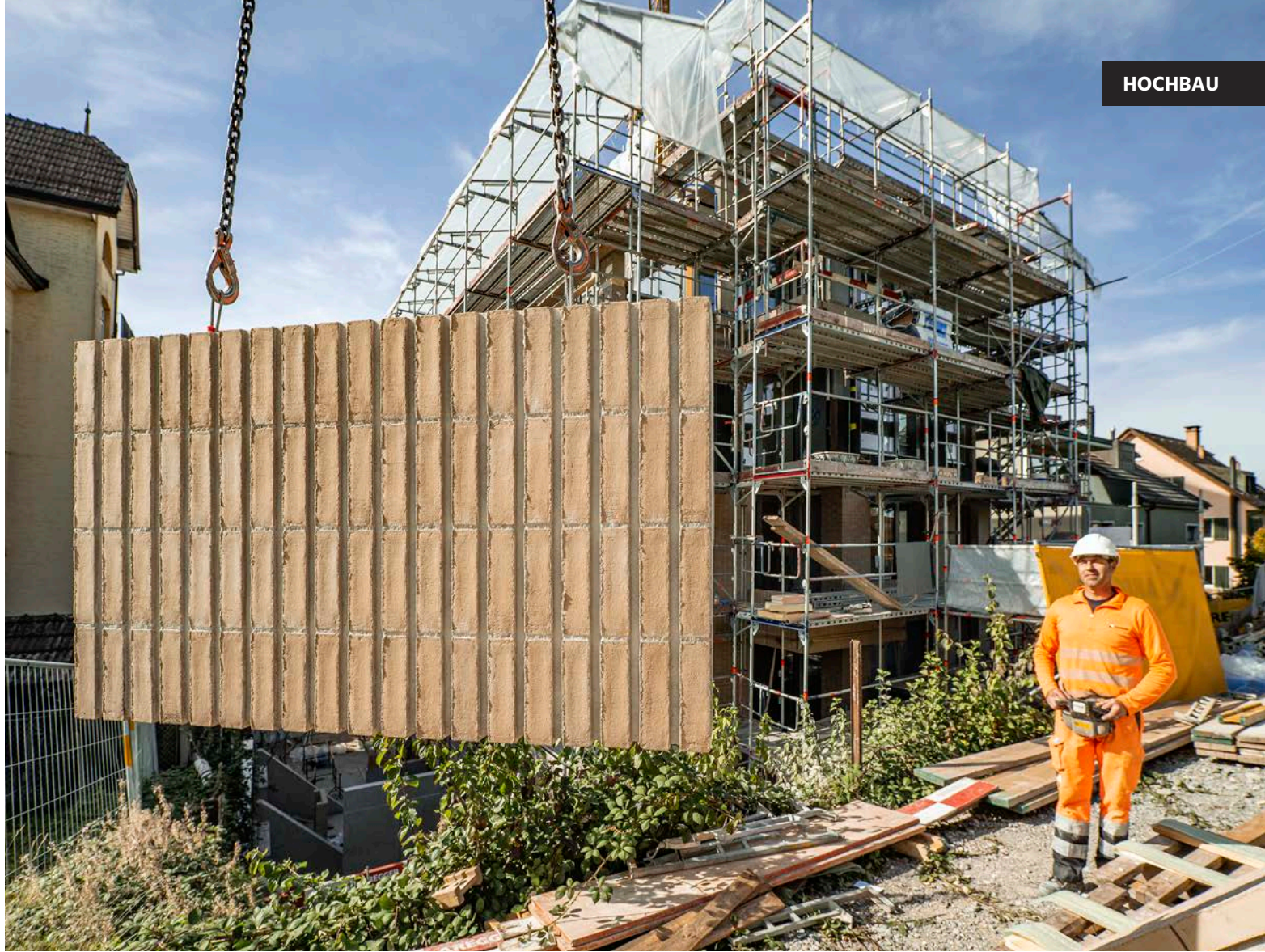
Martin Lipp transportiert ein vorgefertigtes Brüstungselement.
