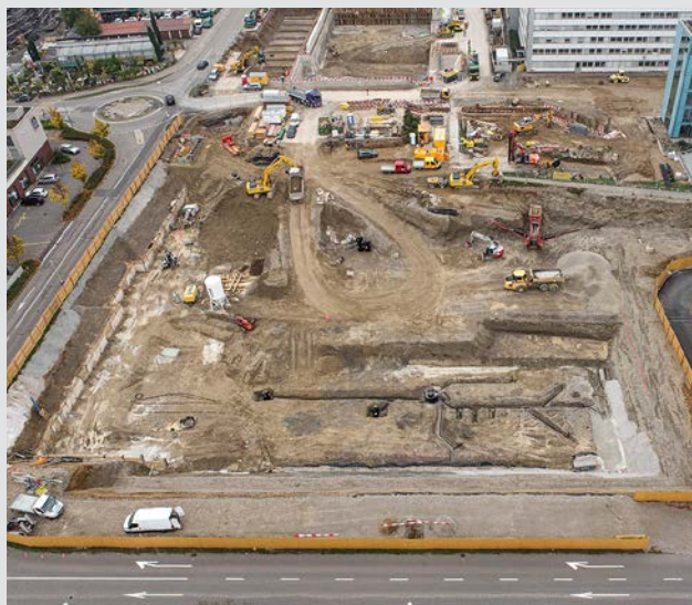
Auf dem riesigen Baufeld sollen mehrere Häuser entstehen.
