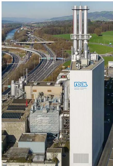
Bild oben: Die KVA Ibach kurz vor ihrer Fertigstellung 1971.
